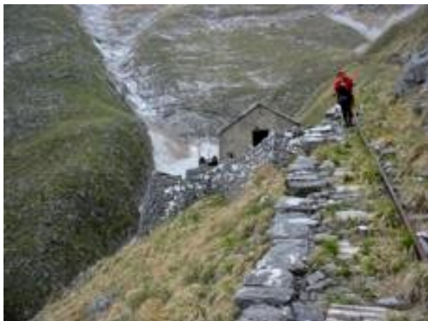
Figura 4: la casa dei macchinari con la monorotaia.
